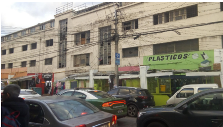
Imagen 1. Fachada del edificio Sanitas por calle Franklin (fuente: Del autor, 2019).
