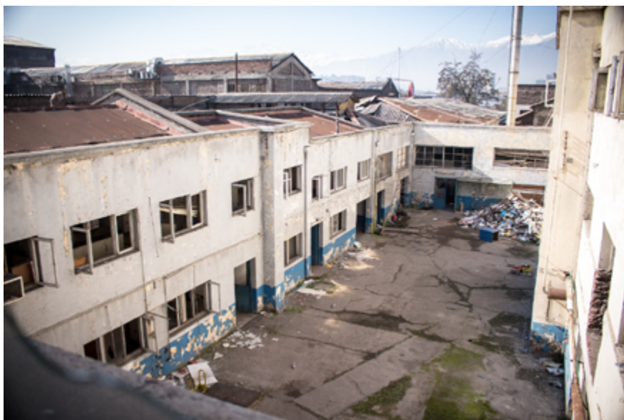
Imagen 2. Interior edificio (fuente: Jaime Astroza y del autor, 2016).
