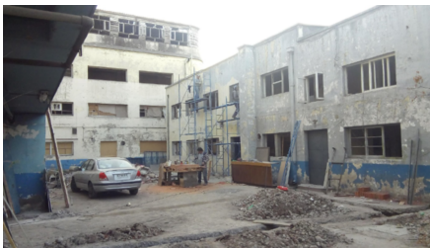
Imagen 3. Interior del edificio en proceso de restauración (fuente: Del autor, 2019).
