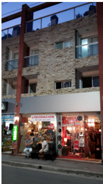
Imagen 7. Renovación edilicia en el área correspondiente al Paseo de las Artes (fuente: De las autoras, 2019).
